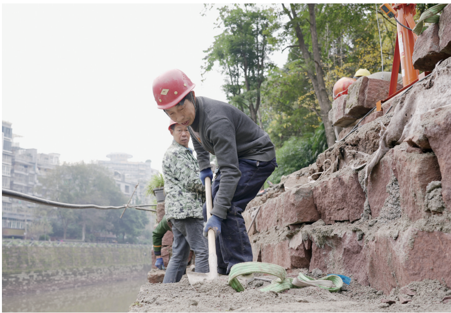
工人正在进行环卫设施修建
